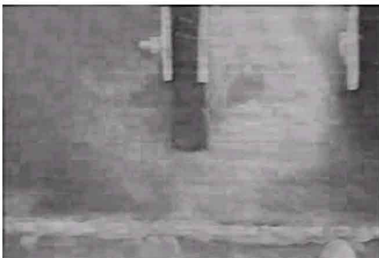
Рис. 4 Подсос избыточного расхода воды через увеличенную щель между соплом очистителя и сеткой
