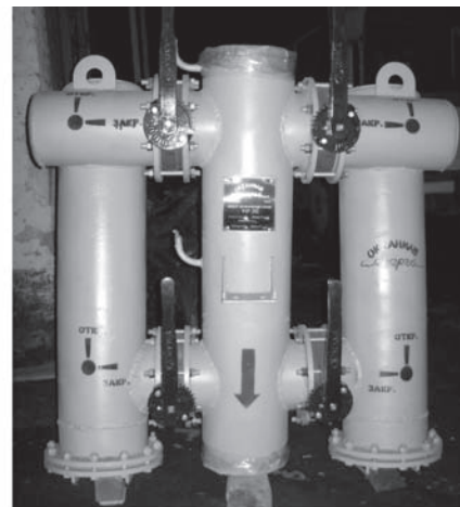
Рисунок 4. Монтажная схема и внешний вид фильтра типа ФДР
