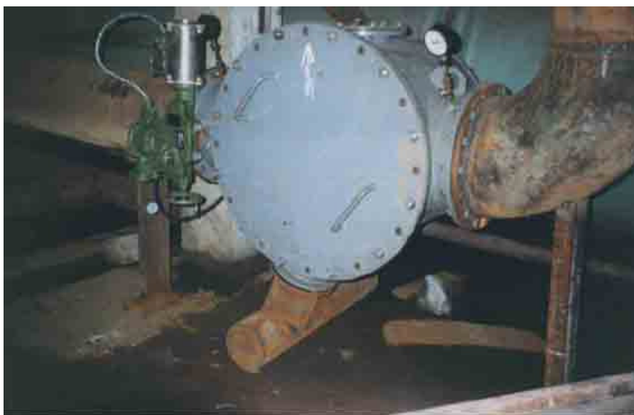
Рис. 3. Фильтр ФСО-400 Океанмашэнерго
